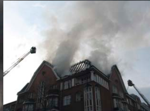
Dachstuhlbrand in der Bouchéstraße
