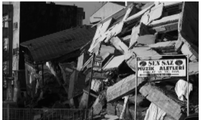
Großes Ausmaß der Zerstörung (Fotos: W. Becher)
